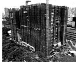
鹿島子会社がシンガポールで 施工中の総合病院
