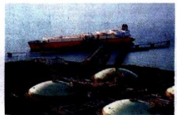
東京電力の富津火力発電所のLNG受け入れ基地。タンクを建設する
