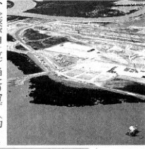
豪州では今後数年で大型LNG開発事業が相次ぎ稼働時期を迎える。北東部開港場の施設。
